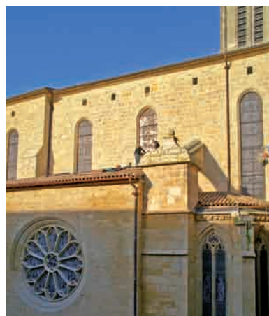
Restauration de la toiture et de la façade, côté sud de l'église Saint-Pierre.
