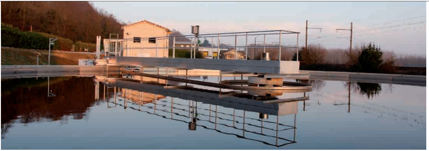
A la sortie du bassin de décantation, l'eau est rendue, propre, au milieu naturel.
