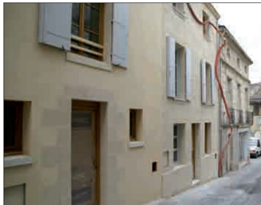
Six immeubles sont en cours de rénovation rue A. Bénac.
